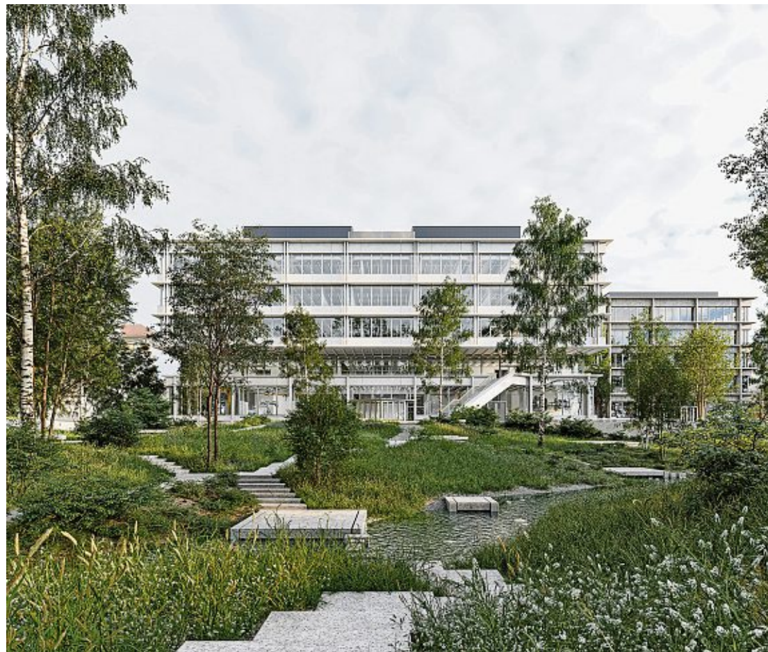
Die Eulach wird auf einer Länge von 380 Metern renaturiert. Trittsteine und Fussgängerstege sollen die Flussquerung ermöglichen. Visualisierung: Baudirektion Kanton Zürich
