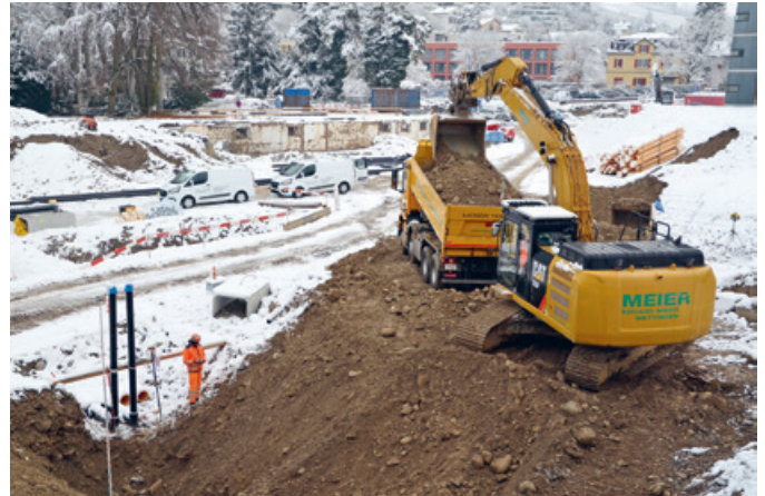
Auch im Winter geht's weiter auf der Baustelle
