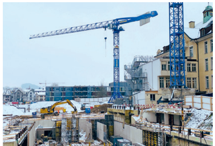
Blick von Westen auf Baustrakt A
