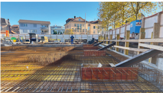
Stahlgitter für die Betondecke der Tiefgarage
