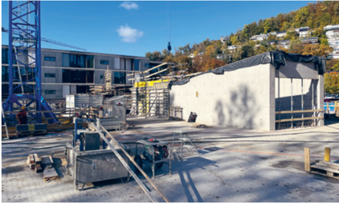
Zufahrt zur Tiefgarage
