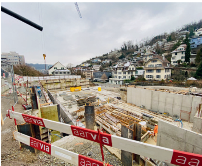
Wände des 2. Untergeschosses Baustrakt A werden errichtet
