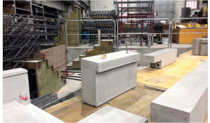
Die ersten (vorfabrizierten) Betonelemente der Loggien (im Werk des Unternehmers)
