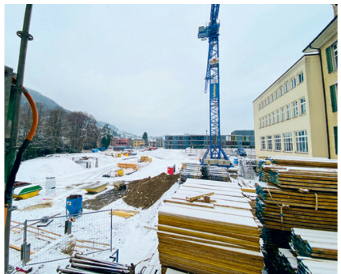
Materiallager für Baustrakt A
