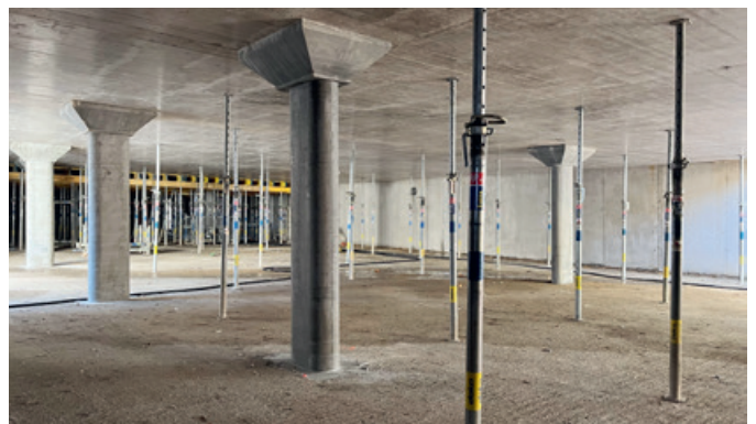
Tiefgarage im Rohbau
