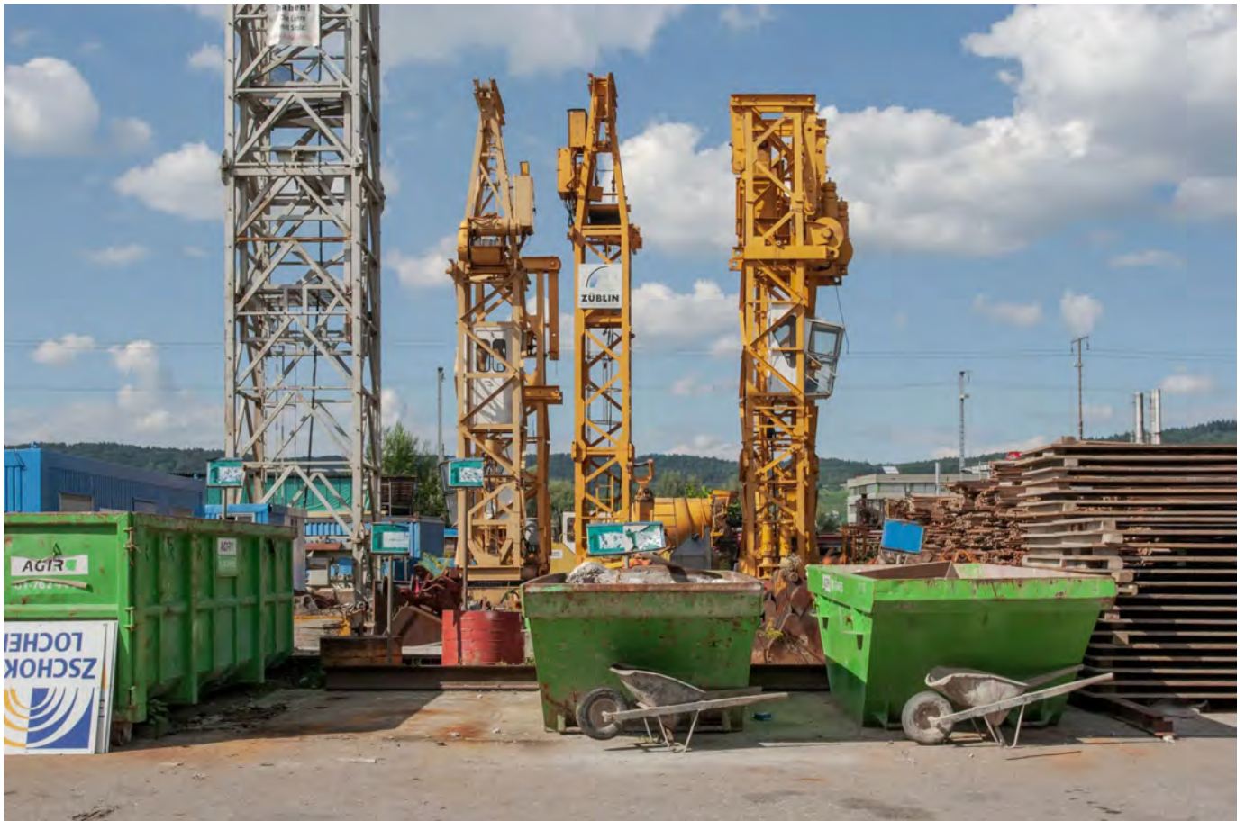
Werkhof und Baulagerplatz Züblin AG an der Badenerstrasse 82 in Schlieren West. (2005)
