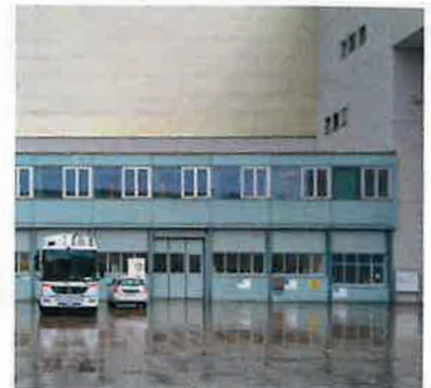
4 KVA Hagenholz: Stahlbau
