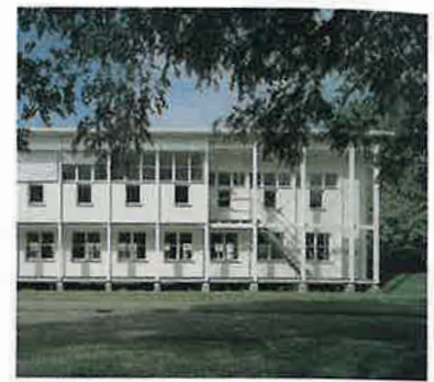
3 ETH-Pavillon: vorfabrizierter Holzbau
