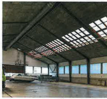
2 Halle Schneider: Stahlbau auf Betonsockel
