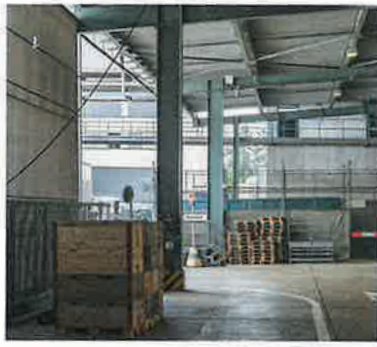
1 Halle Hagenholz: Stahlbau
