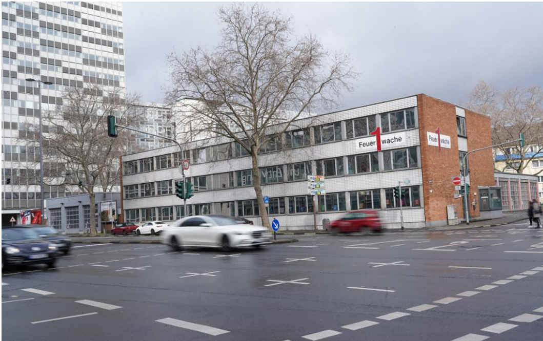
So sieht die Feuerwache 1 in Köln aktuell noch aus © Stadt Köln
