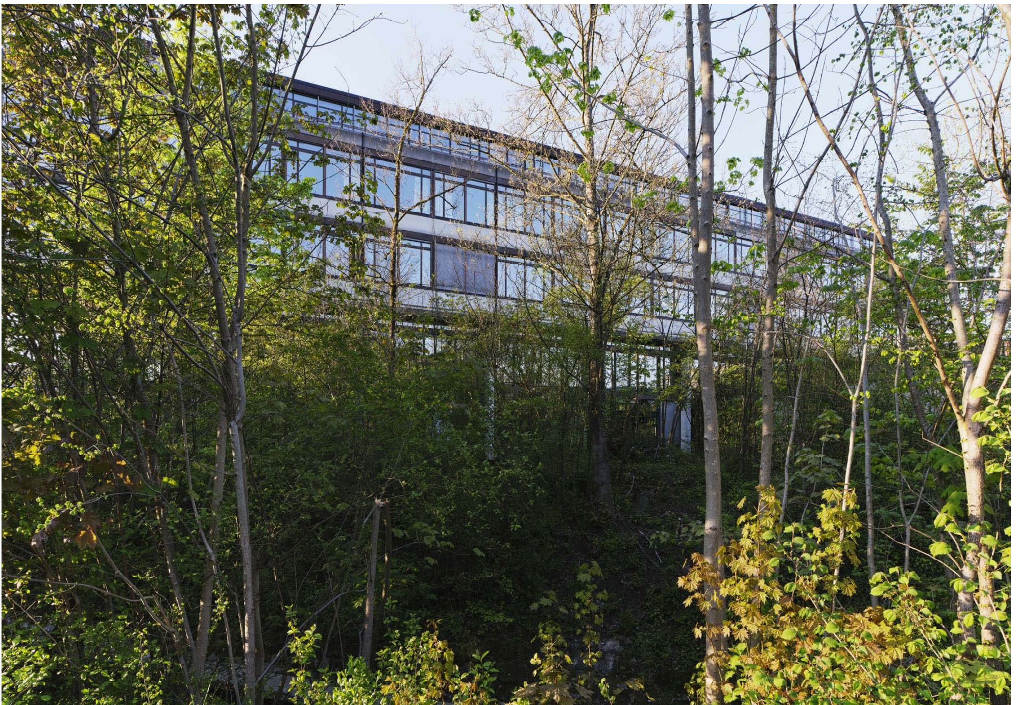
Ebenfalls im Verlauf der ersten Etappe wird das Gebäude mit Bibliothek und Mensa zurückgebaut, damit der Park realisiert sowie die Eulach renaturiert werden können.
