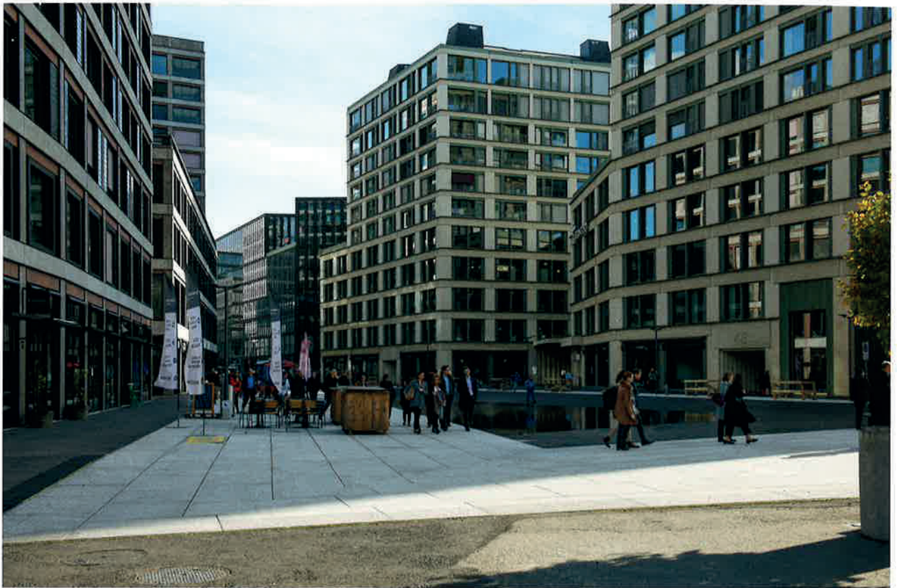
Der Gustav-Gull-Platz in der Verlängerung der Kanonengasse ist von Wohn- und Bürobauten eingefasst . (links Boltshausen Architekten, rechts Caruso St John Architects / Bosshard Vaquer Architekten).
