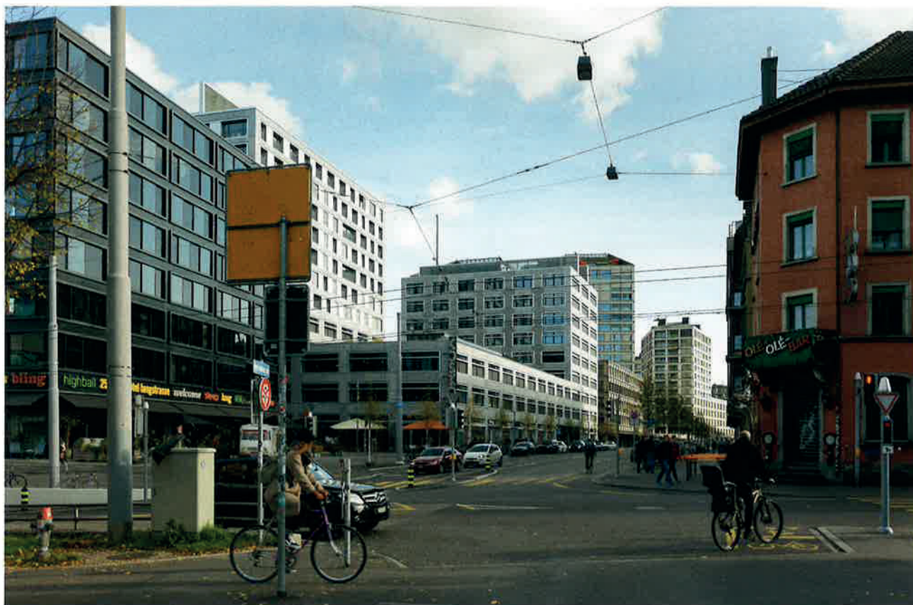
Der Abschluss der Europaallee an der Langstrasse mit Hotel, Kulturzentrum «Kosmos», darüber Wohnungen und Büros. Der flache Bau des Kulturzentrums vermittelt zwischen den Höhenunterschieden von Strassenniveau und umgebenden Fassaden (E2A Architekten).
