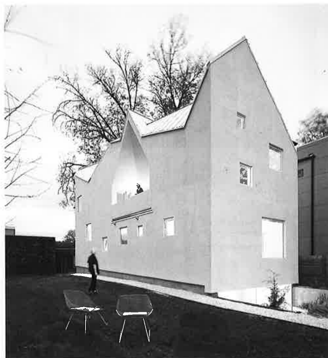
Das Wohnhaus mit sechs Giebeln steht in Atlanta. Architektin ist Jennifer Bonner.
