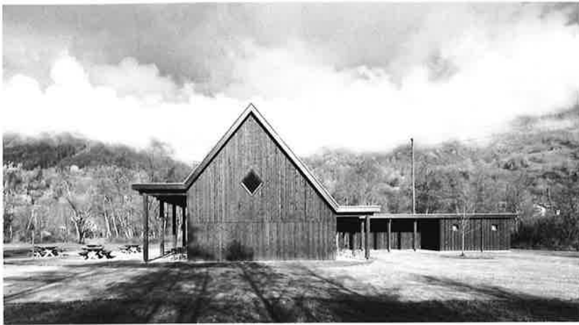
Konstruktive Asymmetrien prägen das Raumerlebnis im neuen Restaurant am Campingplatz Campadi Trun in Graubünden, Architekt ist Iso Huonder.
