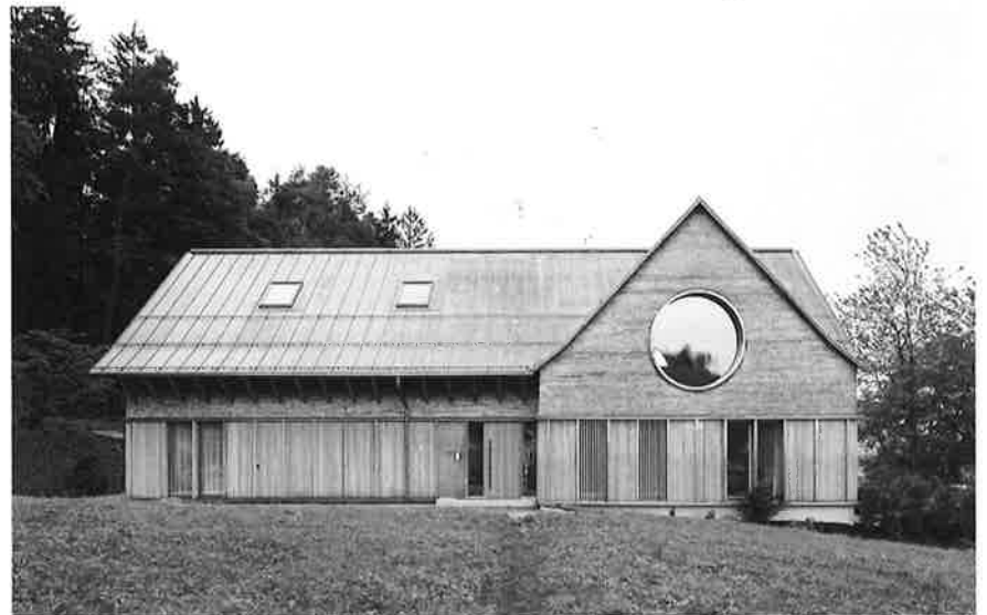
Innauer Matt sind bei dem Haus im vorarlbergischen Weiler den Umrissen des Vorgängerbaus gefolgt, bis hin zum Dach seiner Kreuzgiebelformation.
