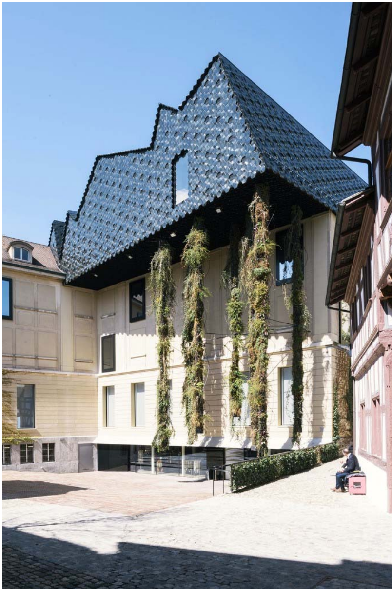
Schimmerndes Museumsdach: Die 1700 Quadratmeter grosse Dachfläche wurde mit sechseckigen, schwarzgrünen Keramikfliesen verkleidet. Foto: Christian Beutler/Keystone
