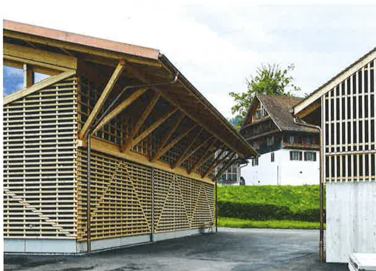
Die grossen Dachüberhänge mit Sprengwerk sind ein markantes Gestaltungselement und bieten Schutz vor der Witterung.
