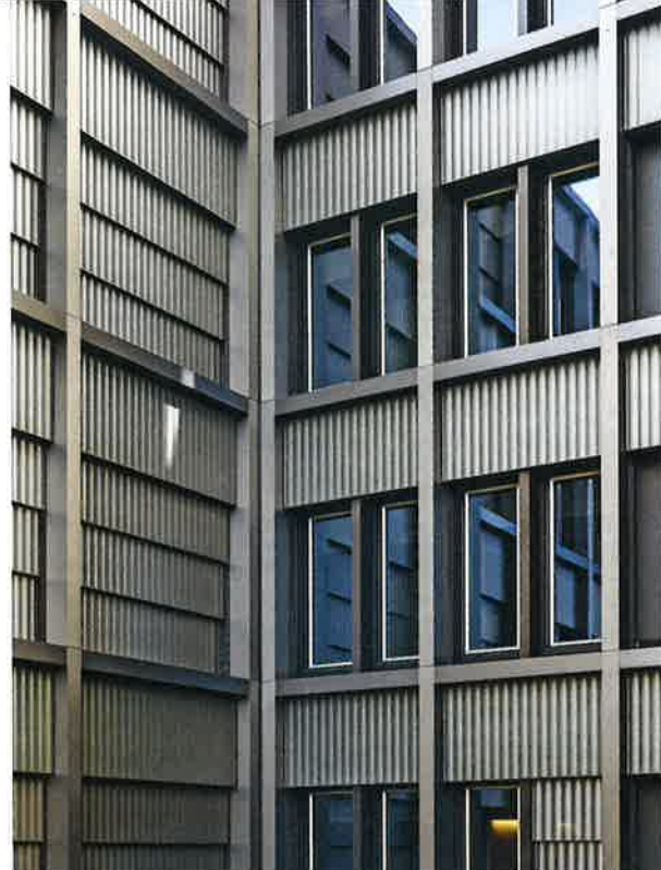
Vertikal verschiebbare Sonnenschutz-Elemente aus bronzefarbenem Aluminium prägen den architektonischen Ausdruck. (Architektur: Graber Pulver Architekten und Masswerk Architekten; Foto: Georg Aerni)
