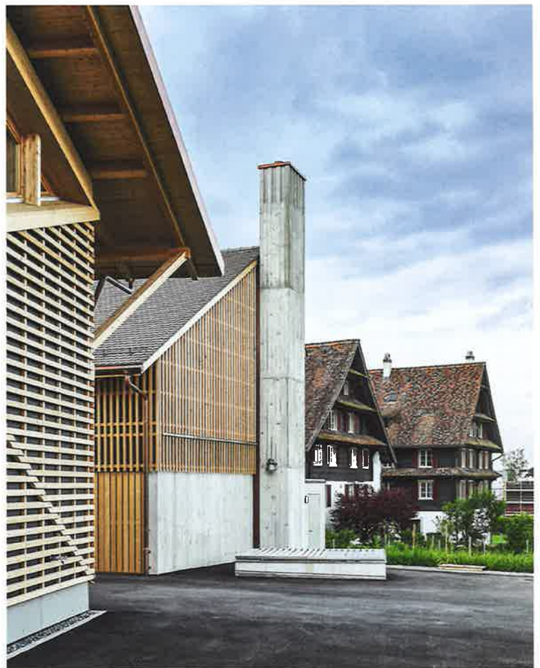
29 Die zwei Neubauten in Zug ersetzen den Bestand der Sechzigerjahre.
