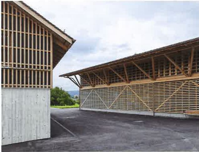
29 Eine offene Schalung aus Weisstanne verkleidet die Fassade.
