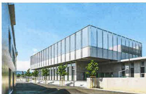
Sportplatz auf dem Dach mit Aussicht auf den Hof.
