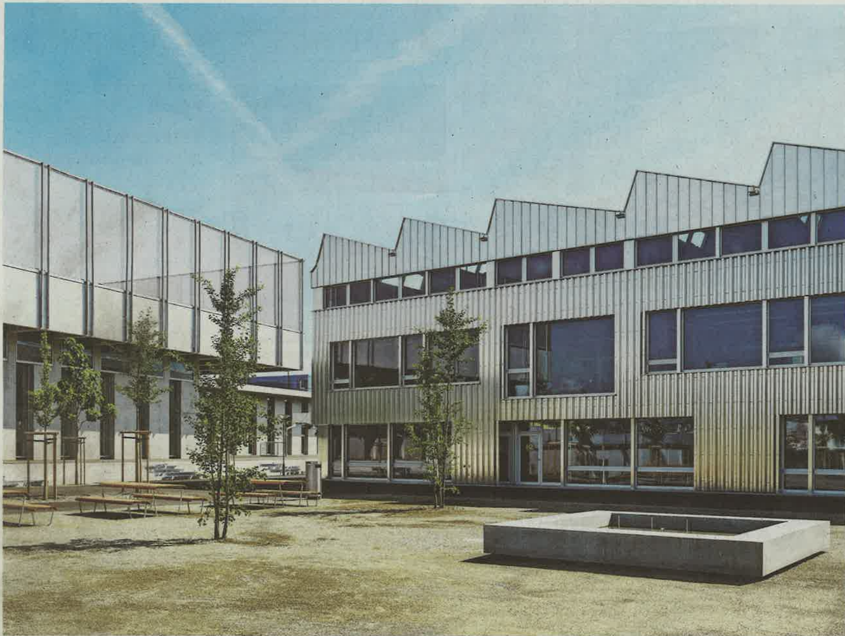
Schulhaus Reitmen: Das silberne Kleid aus Metall und die Sheddächer erinnern an alte Fabrikgebäude (l.) Allzweckplatz auf dem Dach der Sporthalle, Sichtbeton-Flure und sich kreuzende Treppen (u.)
