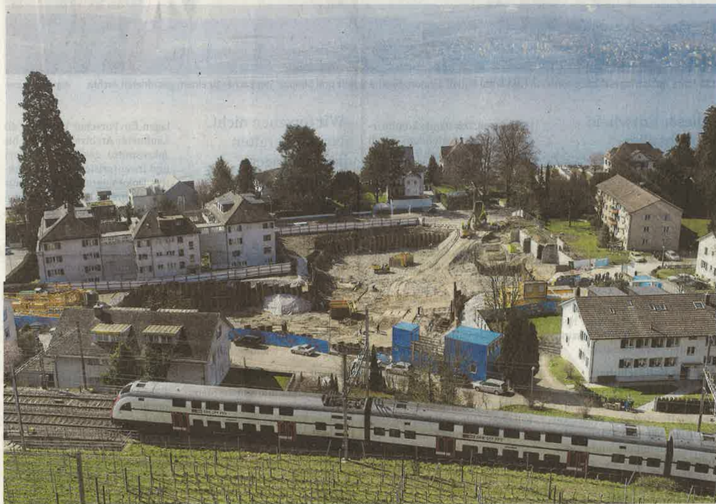
Aus dieser Grube wächst das neue Zuhause von rund 100 Senioren: Der Neue Gehren in Erlenbach.
