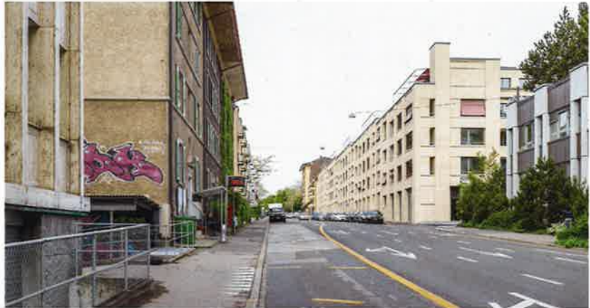
Die Wohnüberbauung Brunnmatt-Ost im Berner Mattenhofquartier: fein modulierte Backsteintektonik an der grossmassstäblichen Siedlung.
