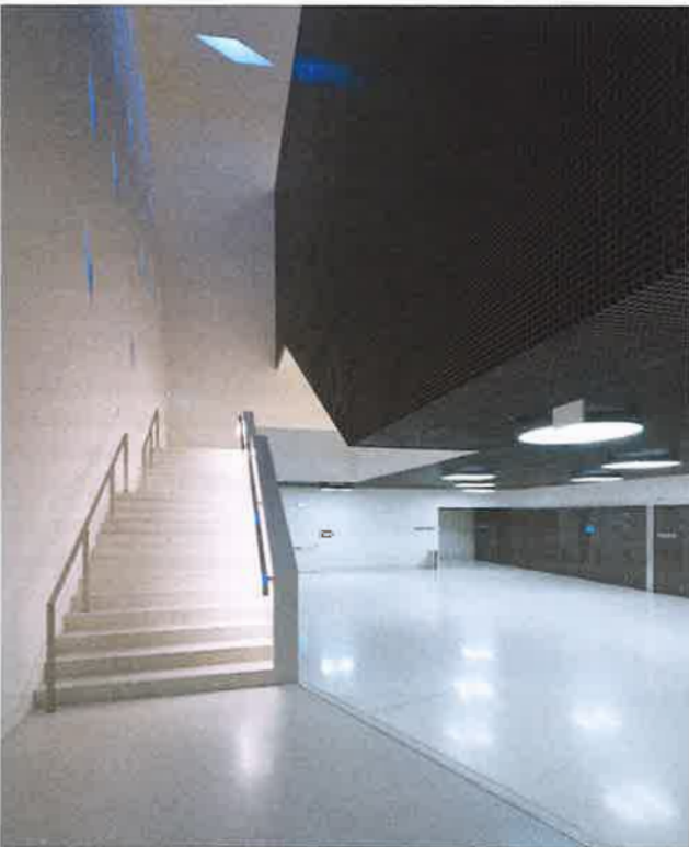
Eine Terrazzotreppe verbindet oben und unten, hell und dunkel. Foto: Leo Fabrizio
