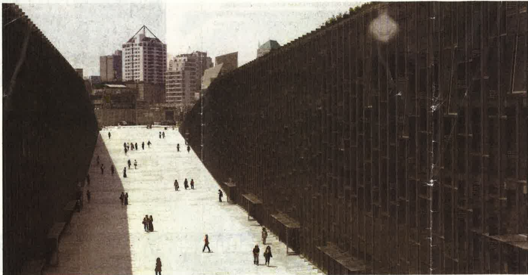
Wandeln zwischen unterirdischen Bauten: Dominique Perrault, Hauptgebäude der Frauen-Universität Ewha in Seoul (2008). Foto: André Morin (DPA, Adagp)
