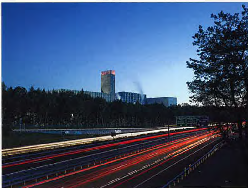
Die Energiezentrale Bern macht die Marke weitherum sichtbar.
