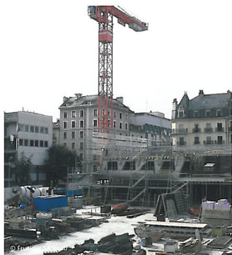
Bereits zeichnet sich die Fassade des künftigen Eingangstrakts ab
