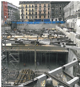
In der ausgespriessten Baugrube sind die Untergeschosse am Entstehen
