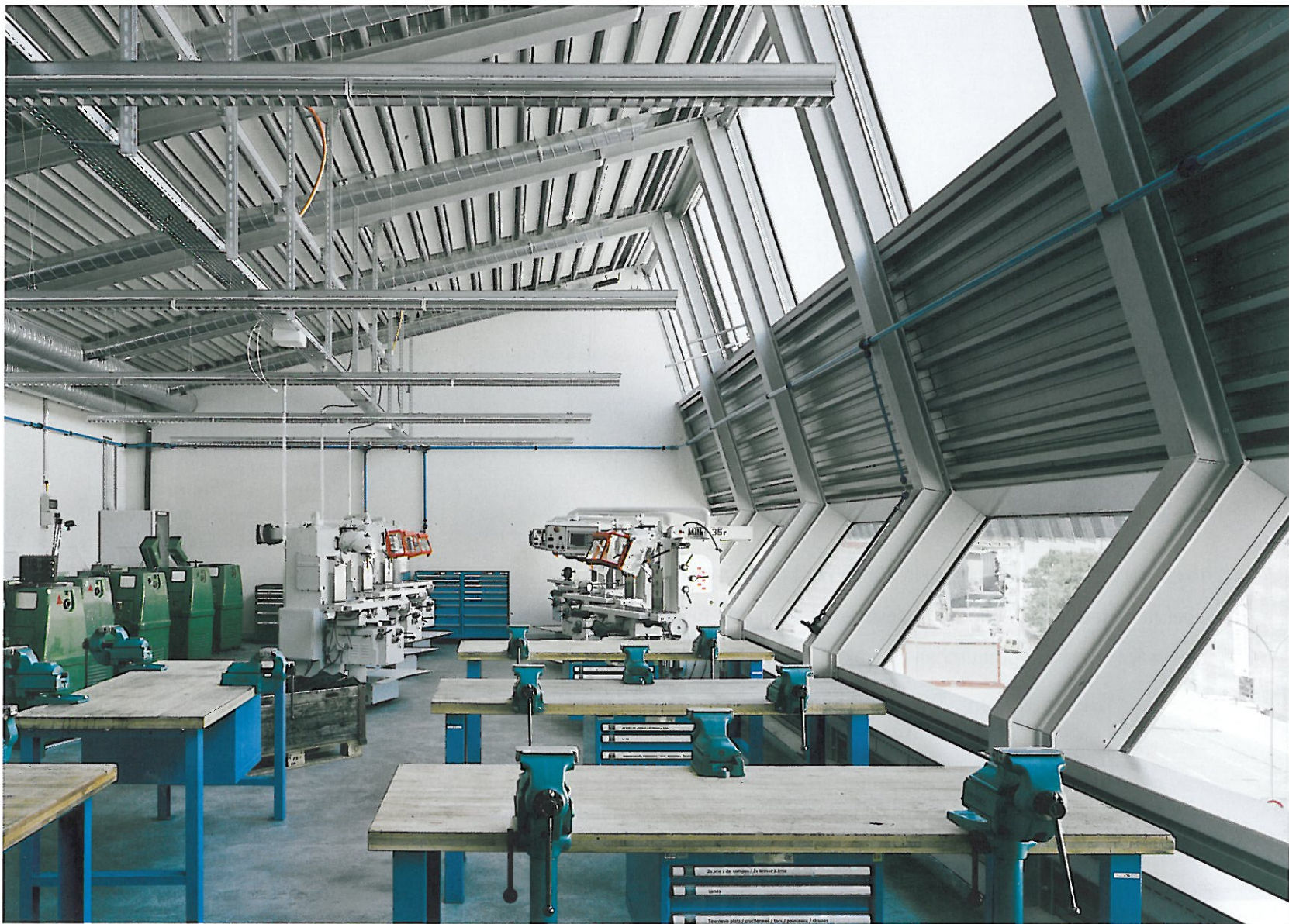
Werkstattraum im 2. Obergeschoss unter dem Shët-Dach
