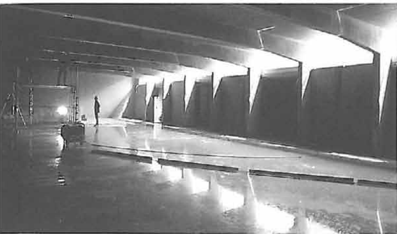
Betonrippendecke im Untergeschoss
