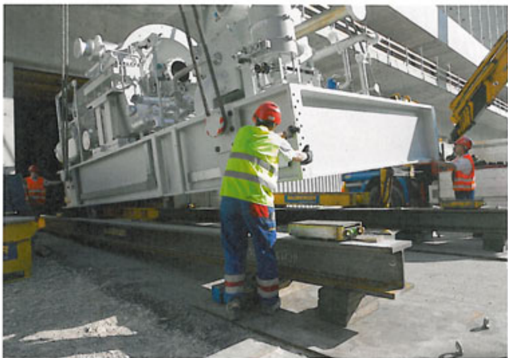
Auf Schienen wird die Turbine an ihren endgültigen Platz im Forsthaus geschoben.
