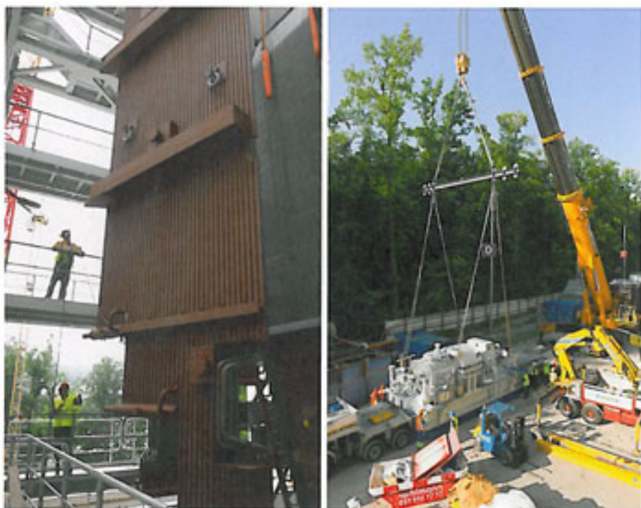
Zweimal Einbau spezial: Links wird die Stahlwand einer Brennkammer, rechts eine der beiden Gas- und Dampfturbinen eingehoben, bevor man anschliessend das Gebäude drum herum baut.
