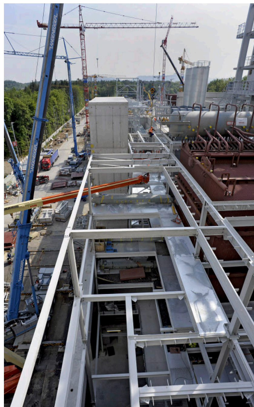
310 Meter in die Länge zieht sich die KVA-Baustelle entlang der Autobahn.
