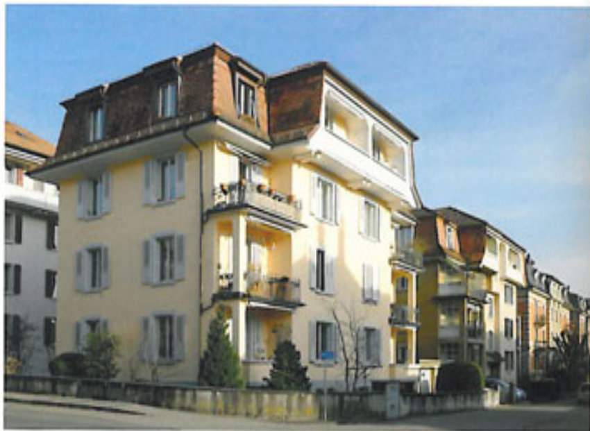
^ Das Vorbild: eine Stadtvilla im Obstbergquartier
