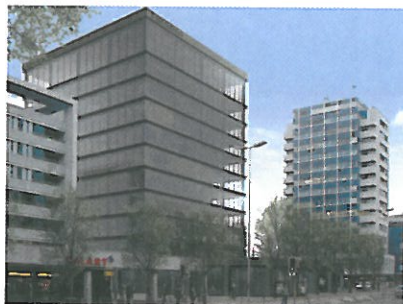
31 Projekt Aufstockung/Gesamtsanierung Zuger Kantonalbank ZKB
