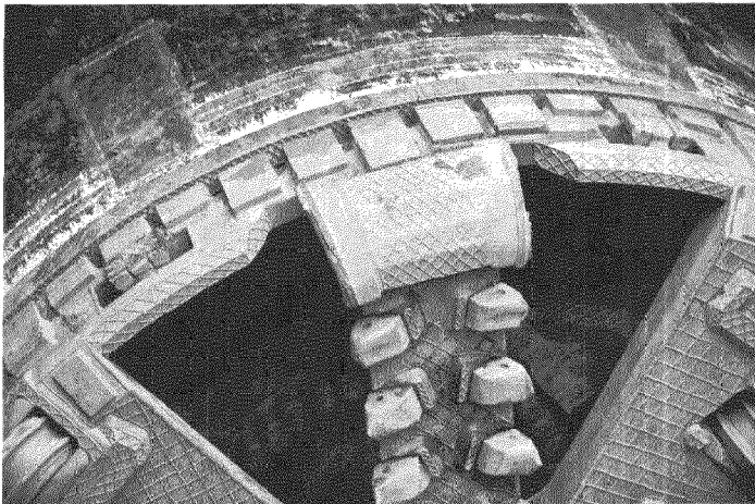
Die Tunnelbohrmaschine hat das andere Ende am Warmbächliweg erreicht. Der Stollen hat einen Durchmesser von 3,6 Metern.
