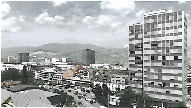
Blick auf die zwei Hochhäuser, im Vordergrund das bestehende AZ-Hochhaus
