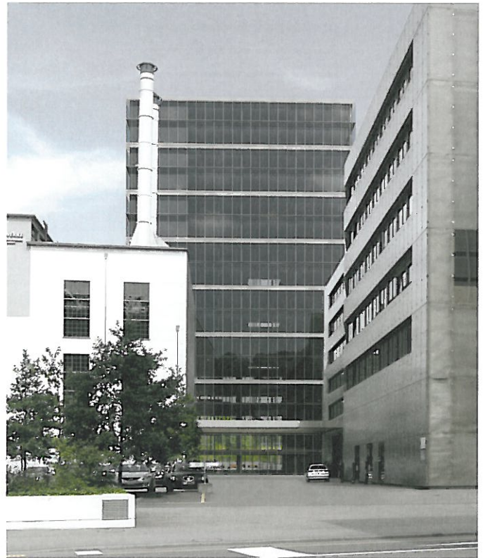
An der Fassade des Hochhauses Nord fehlt bei jedem zweiten Geschoss das Betonband.
