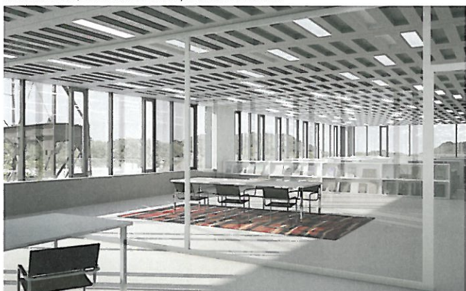
Rippendeckenplatten für eine maximale statische Höhe und minimalen Betonverbrauch
