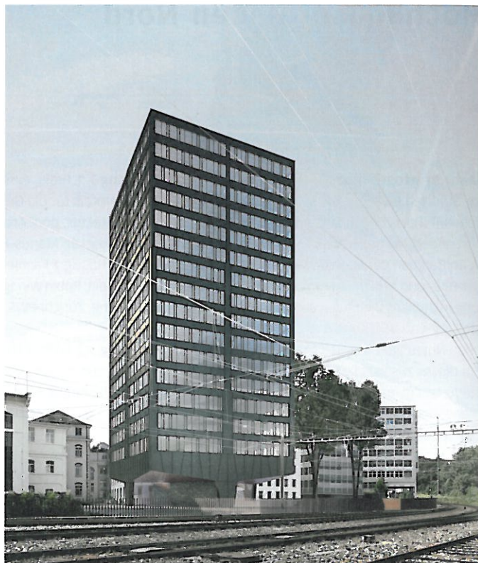
Die metallene Hülle zeichnet genau die darunterliegende Tragstruktur aus Beton nach.
