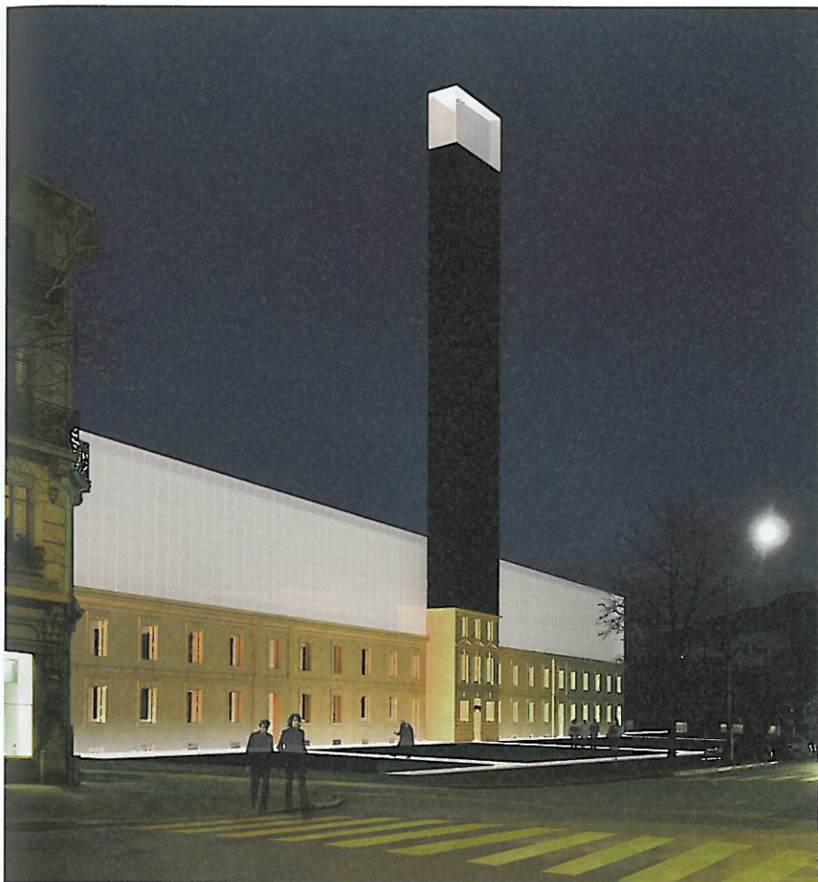
Forte présence urbaine avec la tour «phare et mirador»
