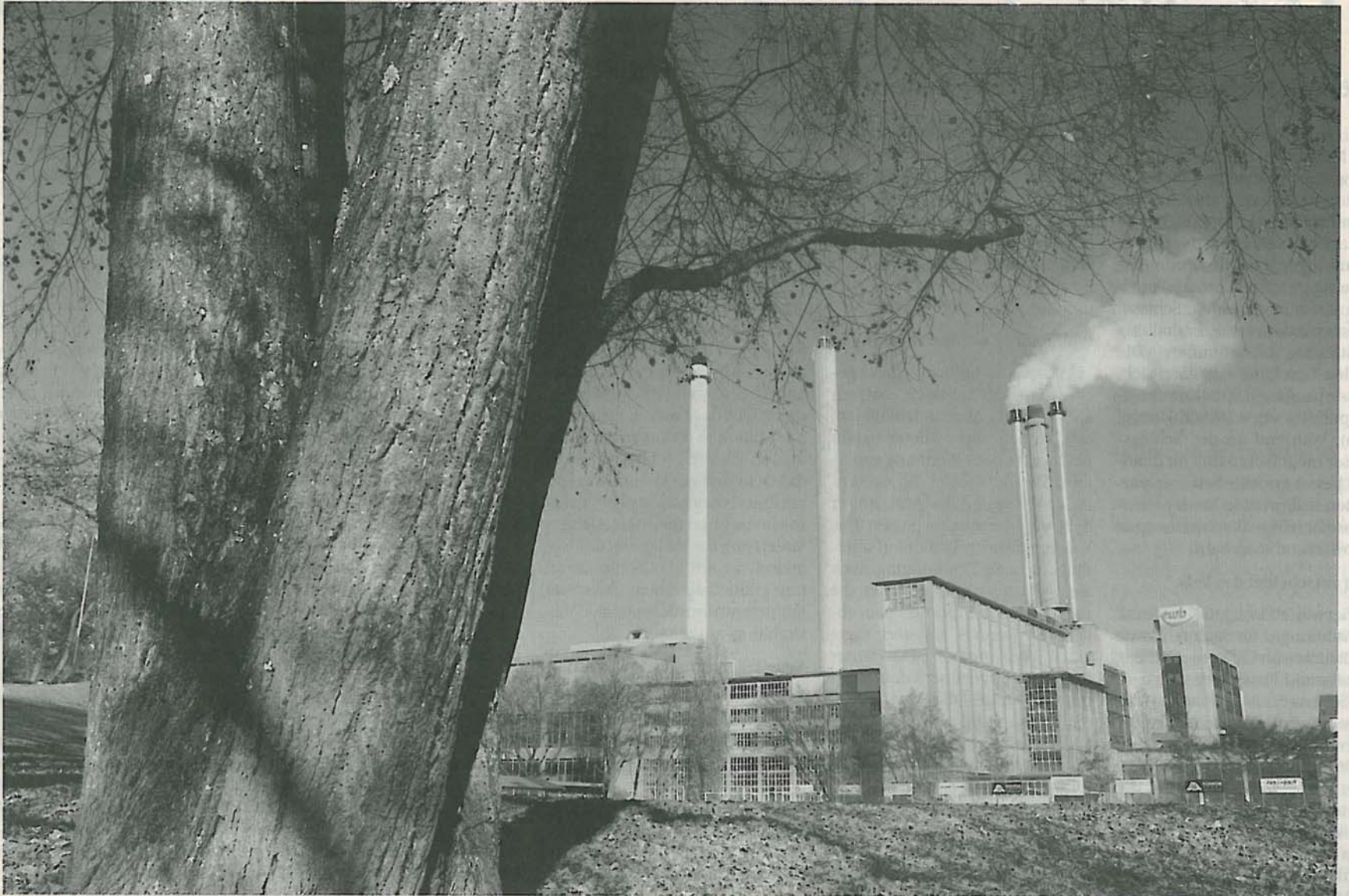
Die Öfen der KVA Bern am Warmbächliweg sollen laut Stadtbehörde 2010 abgestellt werden. Das Areal sei fürs Wohnen geeignet.
