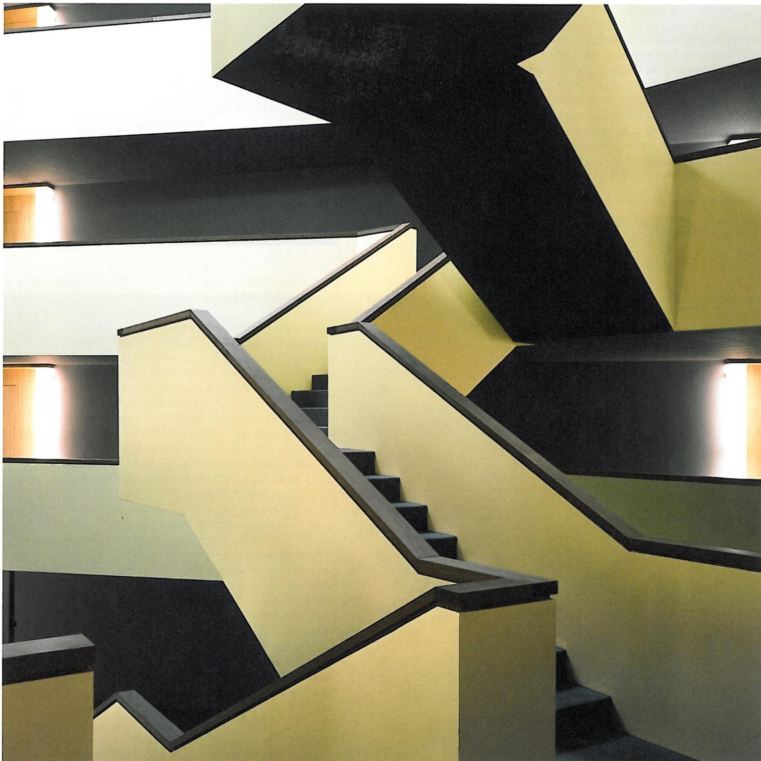
Die Winkelstufen der Treppenskulptur sind aus Hartbeton geschalt, die Brüstungselemente bestehen aus Stahlbeton mit einem Handlauf aus Eichenholz. Der Eindruck reduziert sich – wie auf dem Foto – eher auf das Grafische, der Abstand zum Erleben der verschlungenen Stufenwege fehlt.
